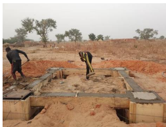
Photo 13. Avance socle château d'eau de la MAEP d'Elou
