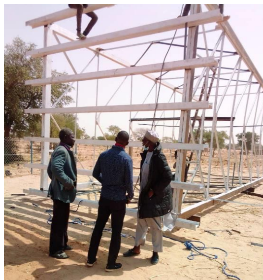
Photo 12. Assemblage de la charpente de l'AEP de Meyreyrey
