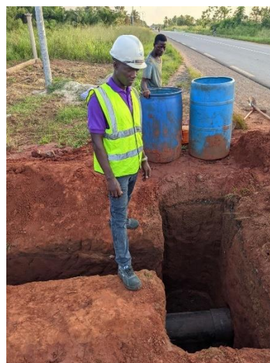
Photo 2. Travaux d'interconnexion des sous-réseaux Anfoin et Aného
